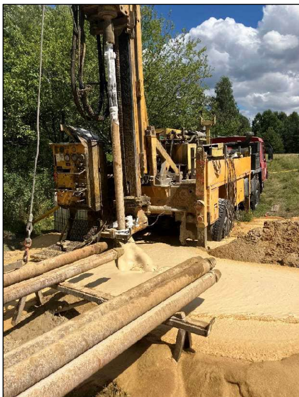
Obr. č. 3: Vrtání za použití vrtné pěny
