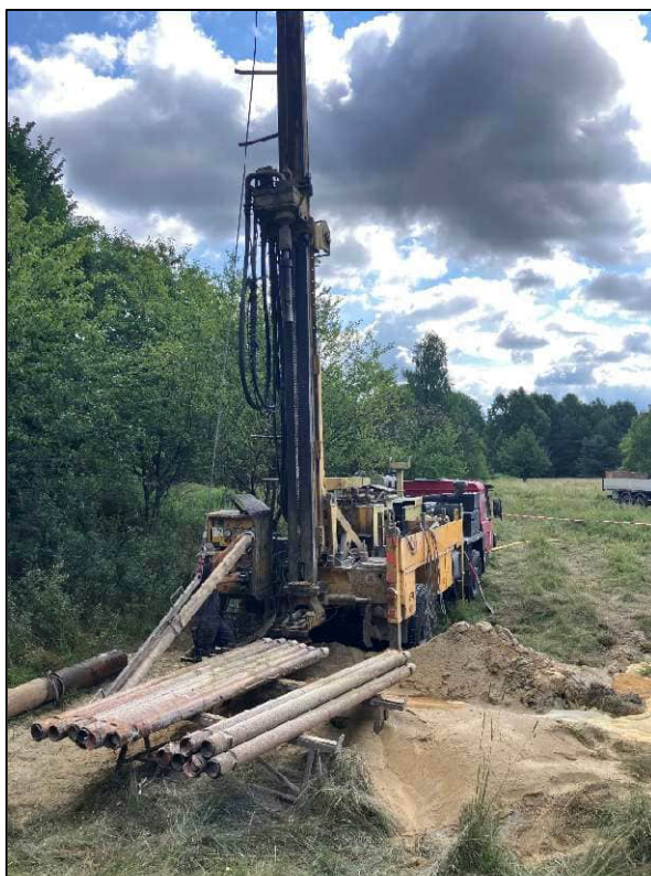
Obr. č. 2: Realizace hydrogeologického vrtu HK-1
