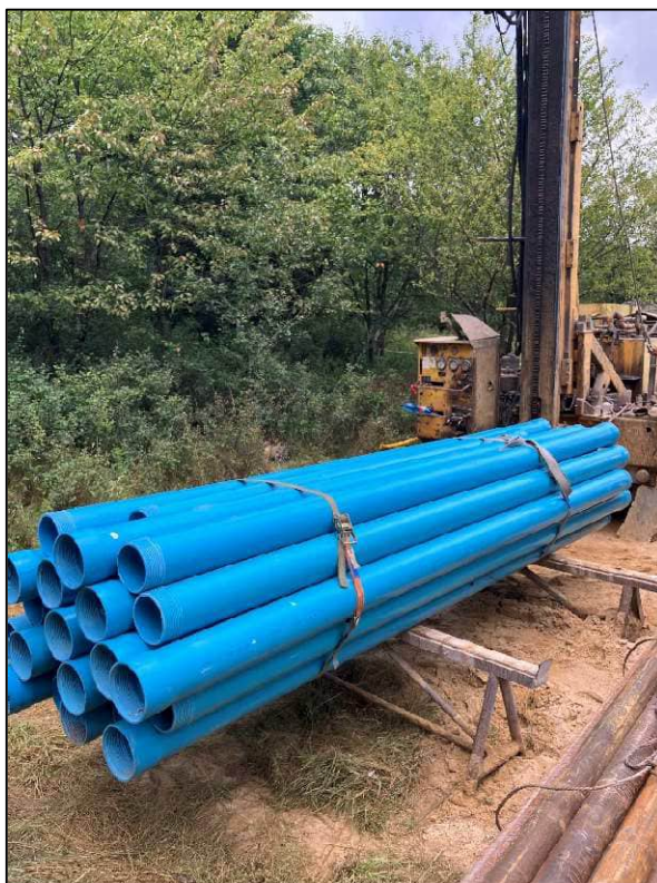
Obr. č. 4: Výstroj 165/9,5 mm, závitová
