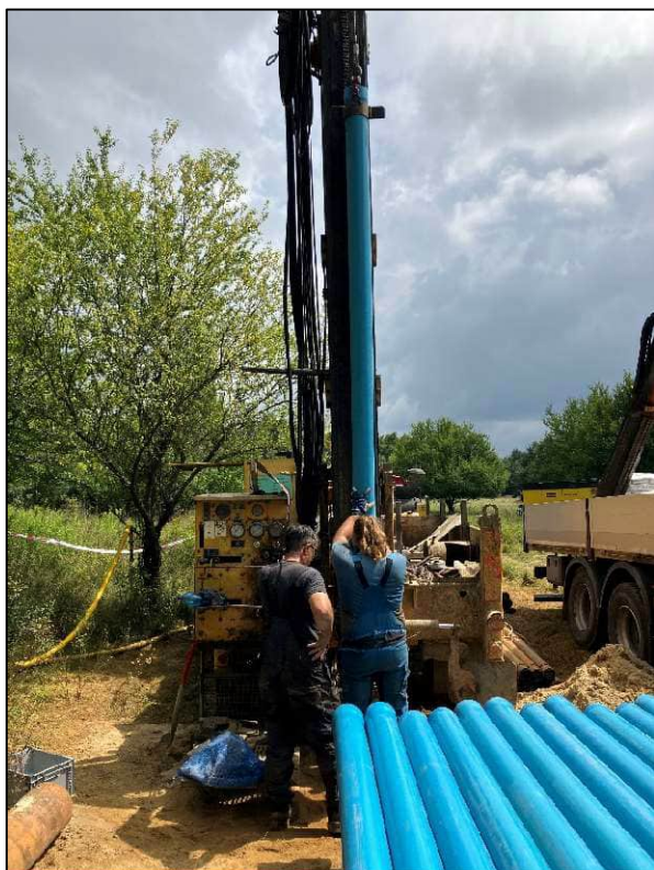
Obr. č. 7: Vystrojovací práce na vrtu HK-1
