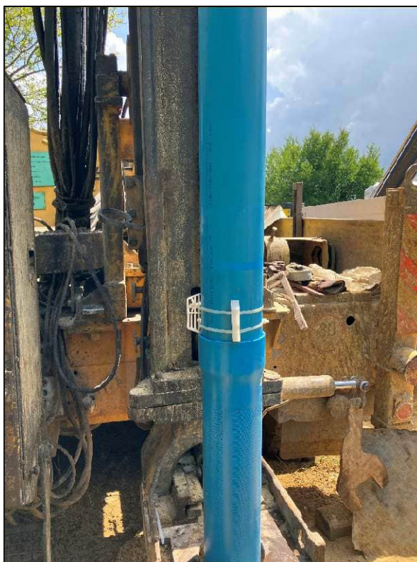
Obr. č. 6: Centrátory na PVC pažnici
