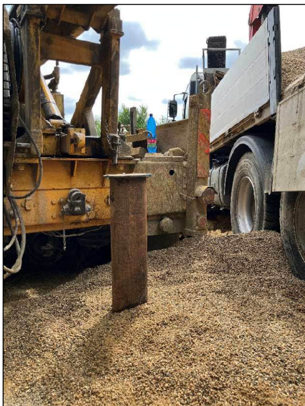
Obr. č. 11: Zabezpečení vrtu Fe převlečnou pažnicí 194 mm
